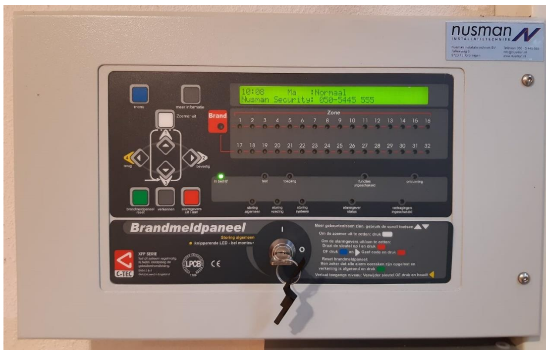
Brandmeldinstallatie bedieningspaneel
